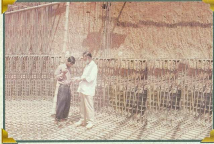
নির্মাণ কর্মী আব্দুল মালেকের সাথে ১নং একাডেমিক ভবনের ফাউন্ডেশন কাজ তদারক করছেন অধ্যক্ষ (ভূমি থেকে ৩০ ফুট নিচে) ফেব্রুয়ারী '৯৪
