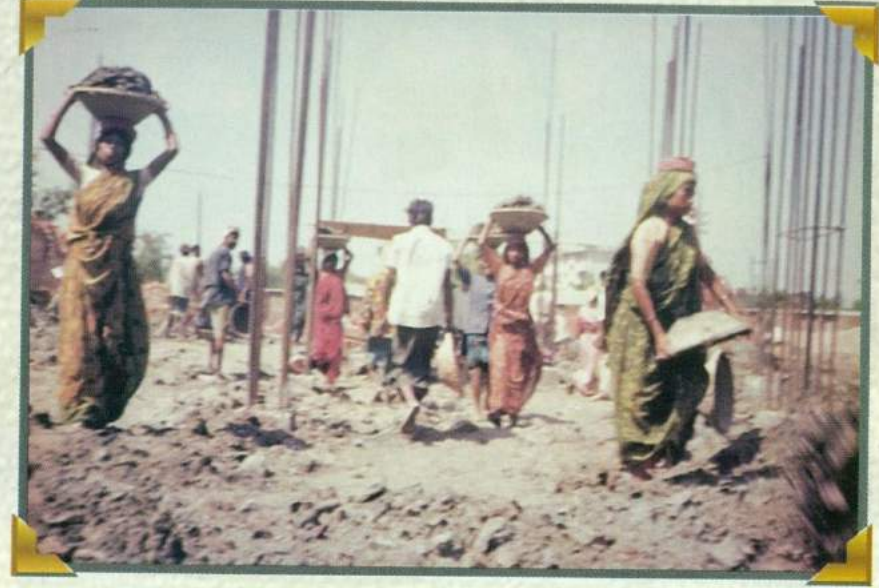
১নং একাডেমিক ভবনের ফাউন্ডেশনের পর মাটি ভরাট
