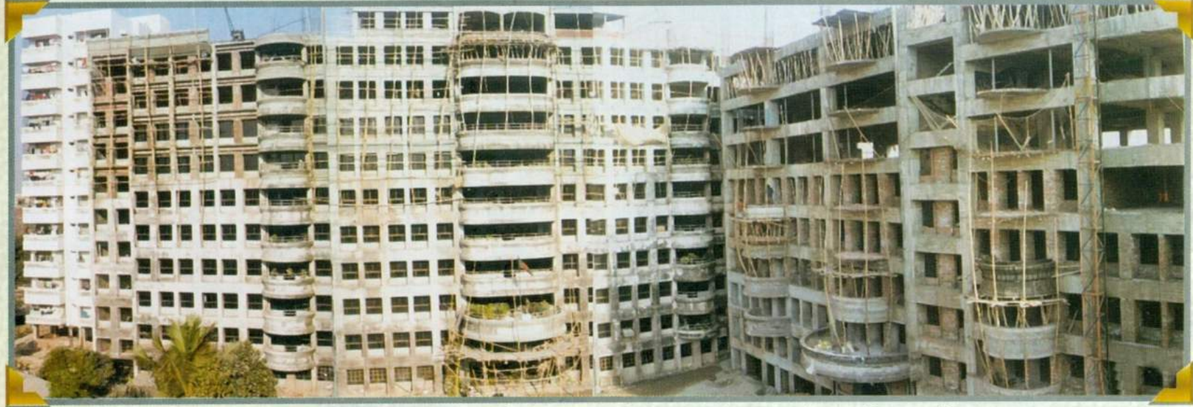
সমাগু প্রায় ১১ তলা ১নং একাডেমিক ভবন (বামে) এবং বিশ তলা ২নং একাডেমিক ভবনের নয় তালার ছাদ ঢালাই চলছে (ছবি: ১ ফেব্রুয়ারী ২০০১) (১ নং একাডেমিক ভবনের ১১ তলায় থাকবে সভা কক্ষ ও অতিথিকক্ষ)
