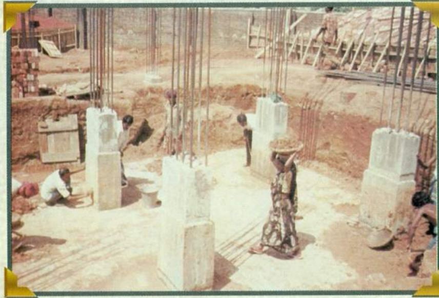
১নং একাডেমিক ভবনের ফাউন্ডেশনের পরপিলার তৈরীর কাজ চলছে (মার্চ ১৯৯৪)
