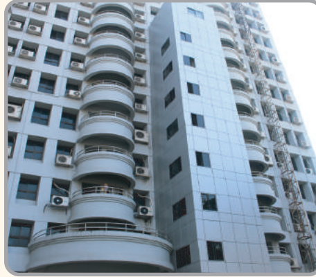
২নং অ্যাকাডেমিক ভবনে নবনির্মিত লিফট
