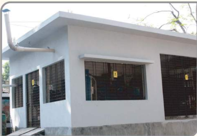
ঢাকা কমার্স কলেজের নবনির্মিত বিদ্যুৎ সাবস্টেশন (২০১৪)
