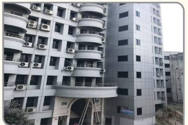
ঢাকা কমার্স কলেজের অ্যাকাডেমিক ভবন ২-এর নতুন লিফট (২০১৬)
